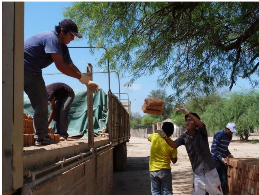
Beim Entladen des LKWs mit Baumaterialien
