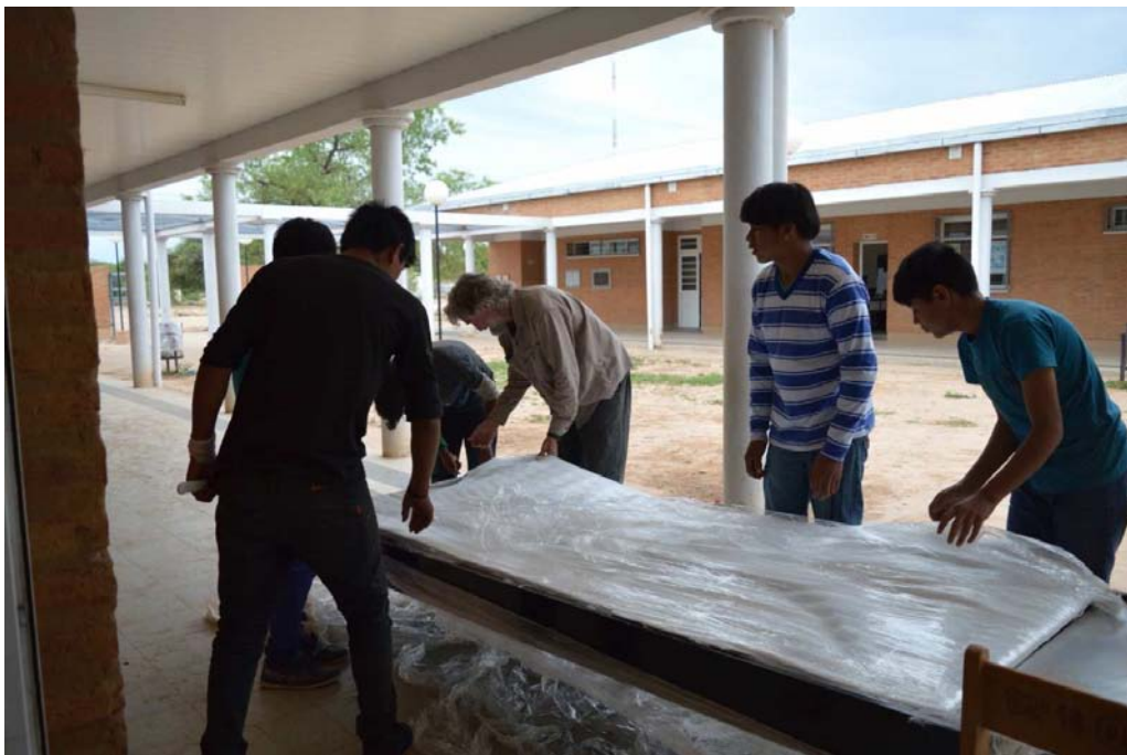
Die Befestigung der Glasabdeckung für den Sonnenkollektor wird vorbereitet. Schüler des ersten Ausbildungsjahrs helfen dabei.
