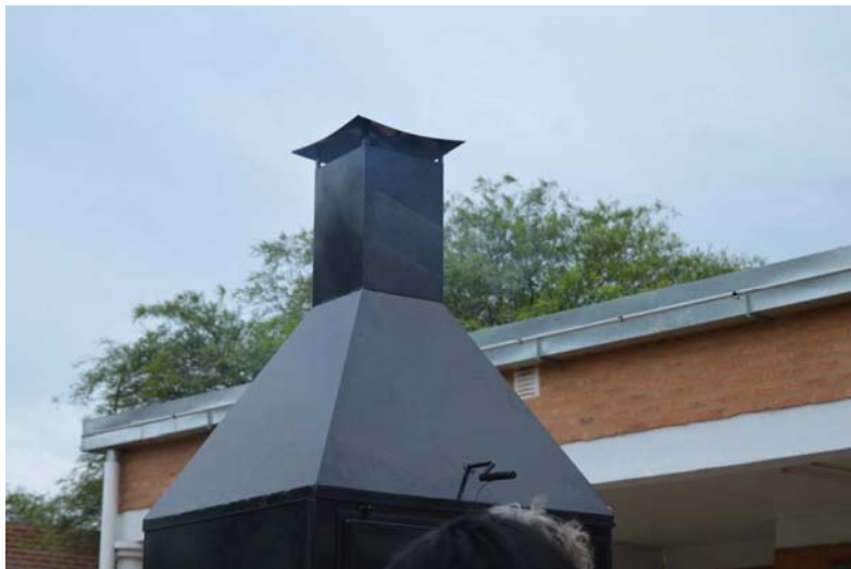
Aus der Abzugshaube dringt der erste Rauch.
