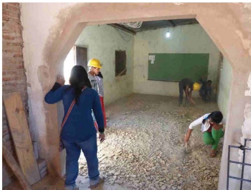
Modificando el interior. La abertura que une los dos ambientes ya está terminada. Anabela remueve el antiguo piso con un martillo
