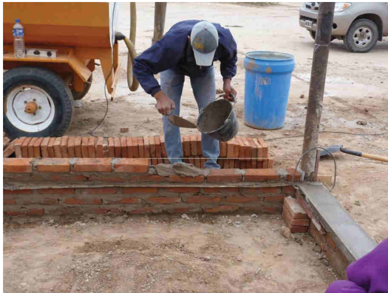
Iniciando la mampostería
