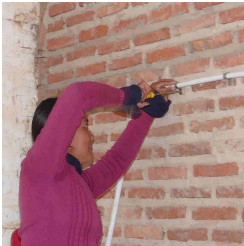
Mariela fija con tornillos la grampa que sujeta los caños.
