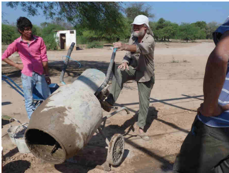
Preparando mezclas para cimientos
