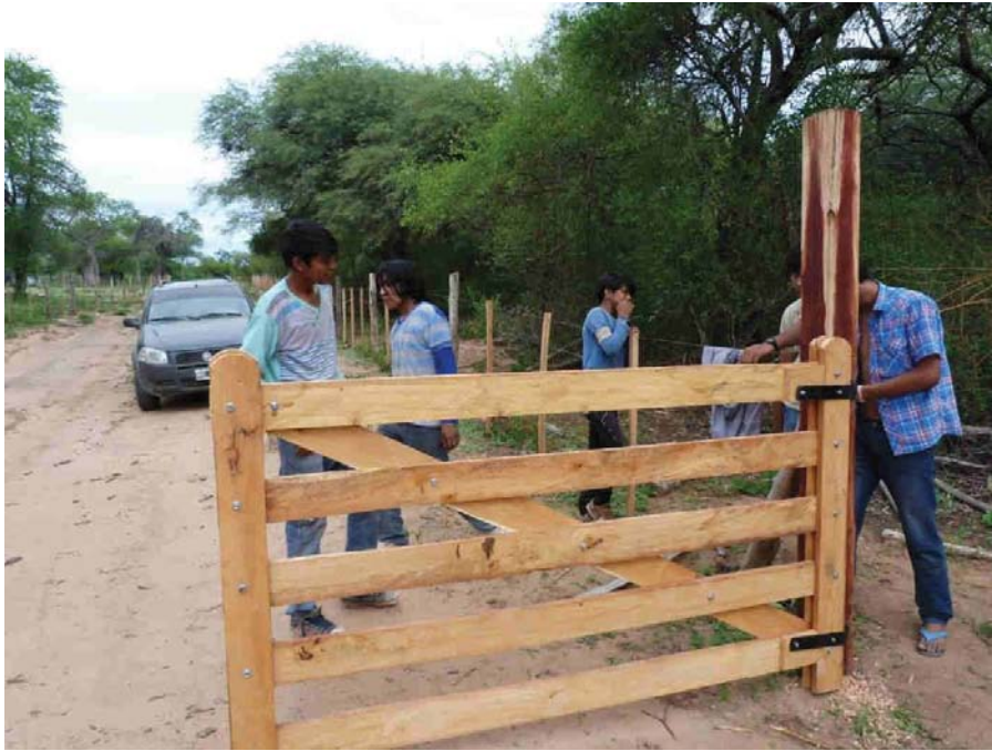
Franklin, Vladimir, Mauricio y Sebastián instalan en su lugar definitivo la tranquera del Campo.
