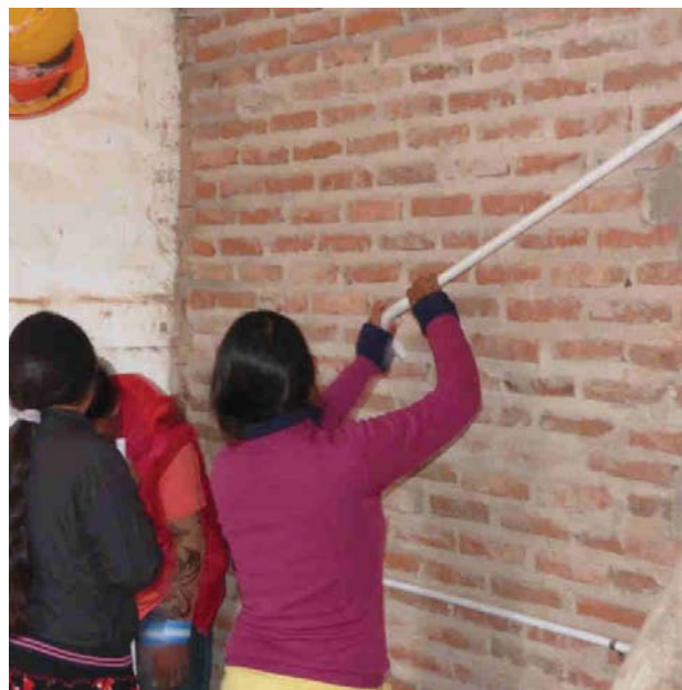
Mariela y María Victoria tienden caños en los muros
