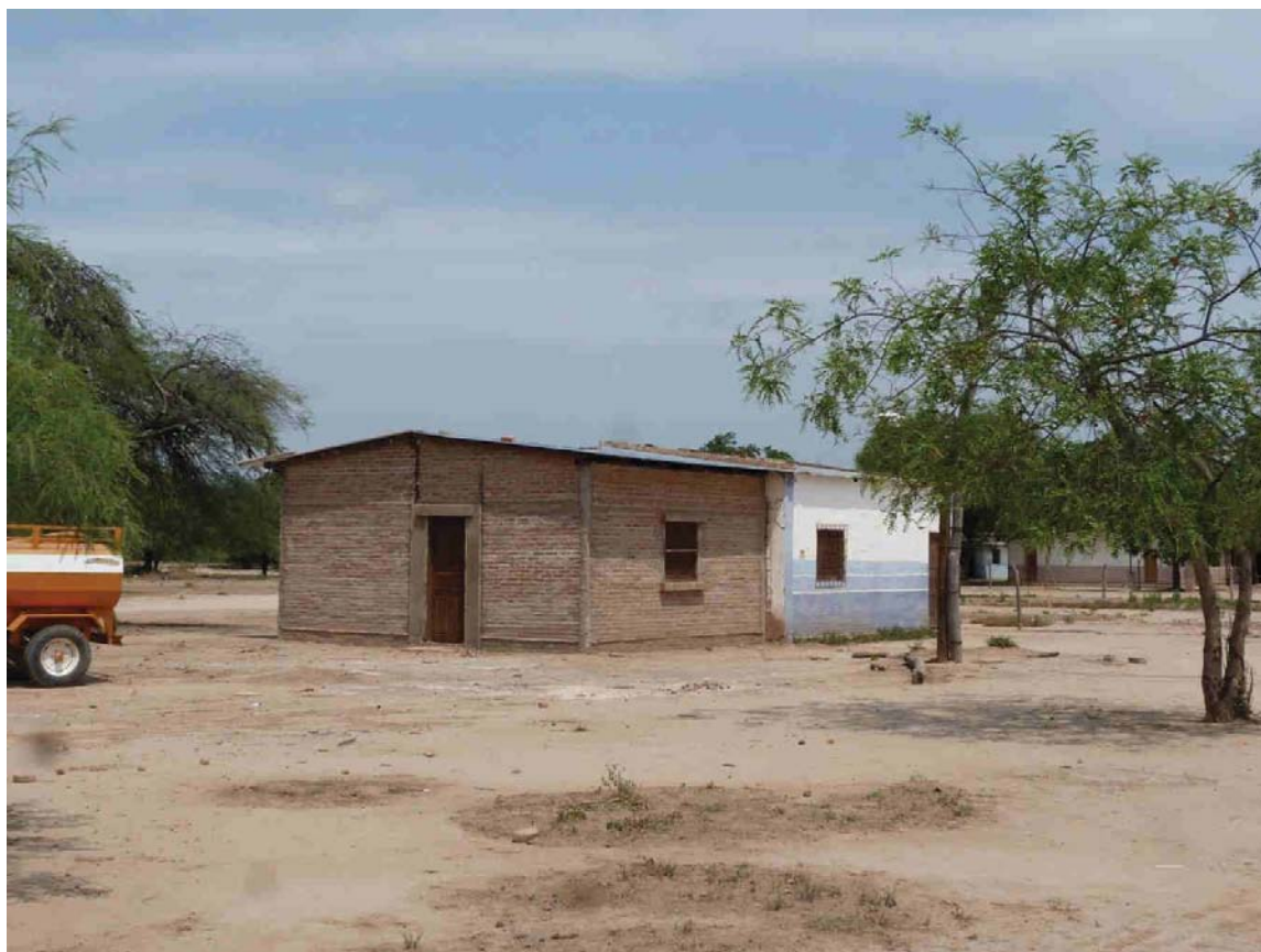
La obra terminada por fuera.
